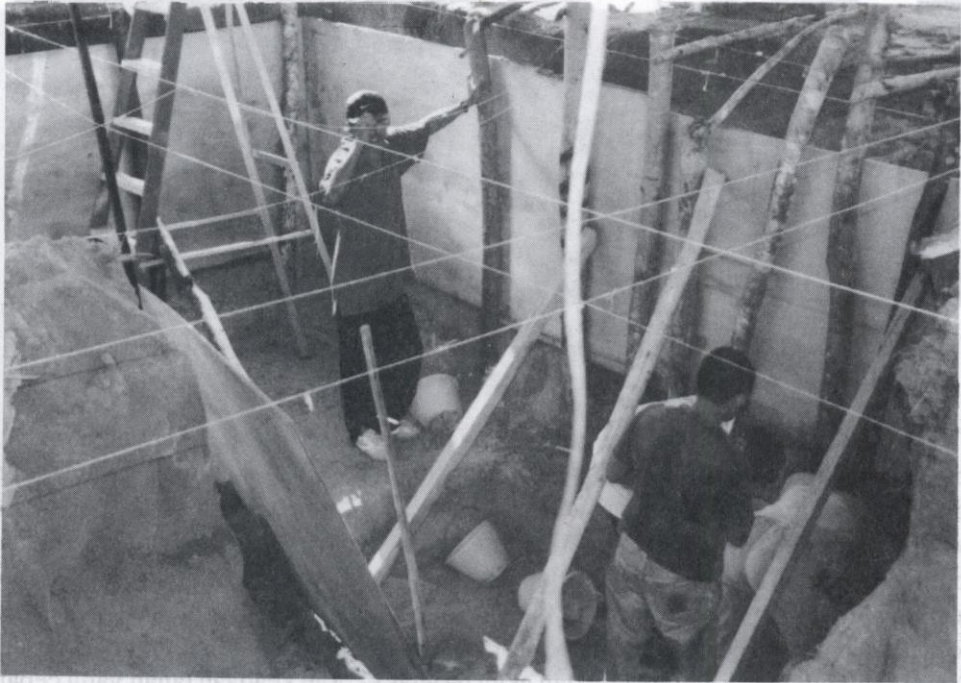
Tapak penggalian terpaksa dipasang dengan kepingan plywood untuk mengelakkan tanah runtuh ketika penggalian dijalankan di Kampung Gaung, Jerteh, Besut, Terengganu pada Jun 1996.
